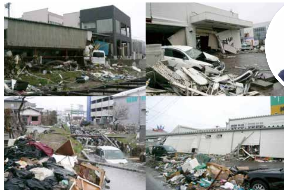
震災時の周辺状況 左上の写真がH様邸
